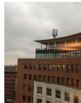
Foto Antenne op daklocatie
